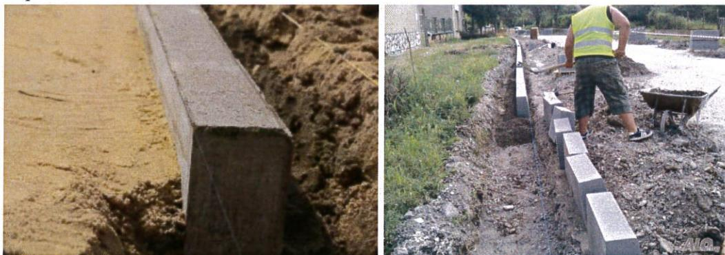
При монтажа ще се предвидят появата на фуги, които са вследствие разширение между съседни блокове. За целта при полагането на бордините ще бъдат фугирани. Преди запълване, фугите ще са поне 5 mm., а след запълване могат да стигнат до 10 mm. По време на монтажа непрекъснато ще се извършва нивелиране и отвесиране.
