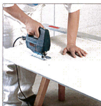
Плочите гипсокартон или гипсофалер се режат много лесно с прободен трион
