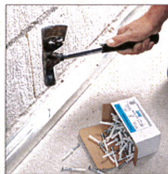
UD или UW профилите се закрепват към пода или тавана с помощта на дюбели-пирони (завиват се с чуку)
