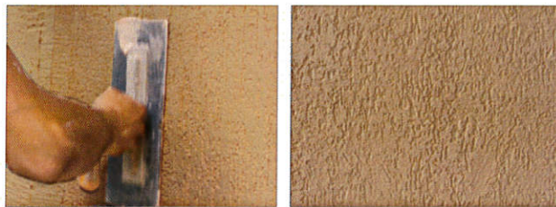
Обформяне на повърхностна структура тип „ламичена“ чрез триене и изглавяне с пластмасова перфаника (маламашка)
