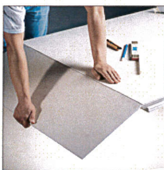
Плочата се изтегля така, че срезът да попадне върху ръба на лежащата под нея, и с лек натиск се пречупва
