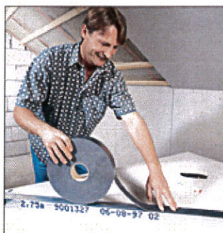
Върху гърба на всеки UD или UW профил се поставя самозалепяща еластична уплътняваща лента
