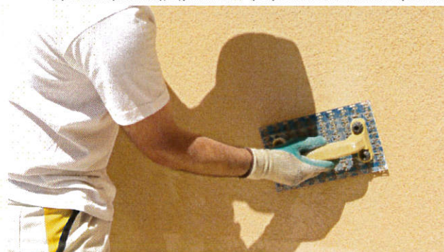
Обформяне на повърхностна структура тип „ламичена“ чрез триене и изглавяне с пластмасова перфаника (маламашка)
