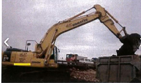
Техническия ръководител регулярно контролира нивото на получения при изкопа хоризонт. При достигане на ниво със 10 см по високо от заложеното по проект се прекратява работата на верижния багер. Останалите 10 см от изкопа се отнемат ръчно и се отстраняват. Това се прави с цел дъното на котлована да е здраво, с не нарушена повърхност.
